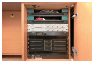
▲ ワイヤレス受信機、増設ワイヤレス受信機(上部)とデジタルパワーアンプWP-DM912(下部)
