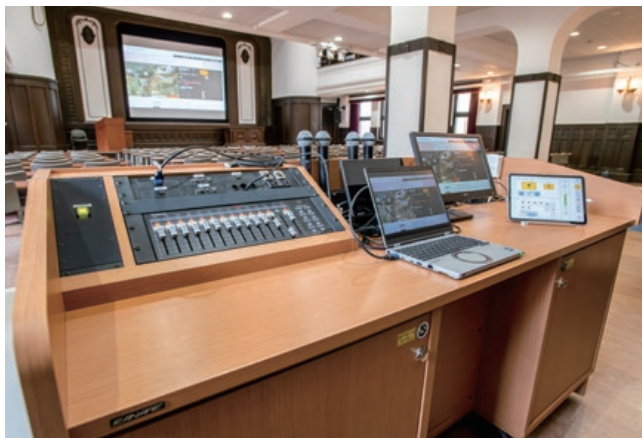
▲ 講堂の後ろに設置されたAV操作卓。右端がAV機器を一括操作できるタブレット端末
