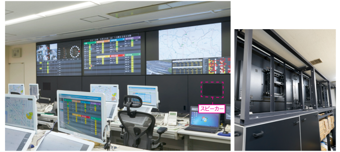
▲IPSパネル搭載により、斜め後方の視認性も確保されている。筐体にはスピーカーが内蔵され、緊急時にはテレビ放送の音声などが流せるようになっている。メンテナンス性を考慮した結果、壁埋め込みせず、背面・端子部にアクセスできる筐体構造に変更
