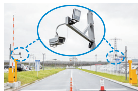
▲車両のナンバーを読み取るi-PROネットワークカメラ
